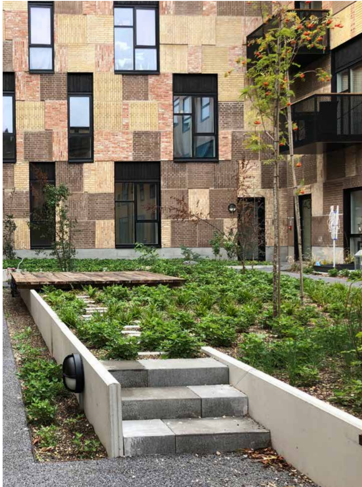
Foto fra Ressourcerækkerne i København af Lendager Group a/s. Her er facad-erne opbygget af genbrugte murstensfacadestykker fra bygninger, der stod til nedrivning. Foto Møller Løkkegaard anlægsgartner.
